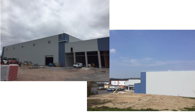
Centre Logistique Frigo
