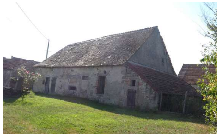
Grange à Barrais-Bussolles
