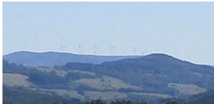
Vue sur un parc éolien (implanté hors territoire) depuis Le Breuil
