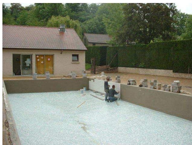
Réfection de la piscine de Bert
